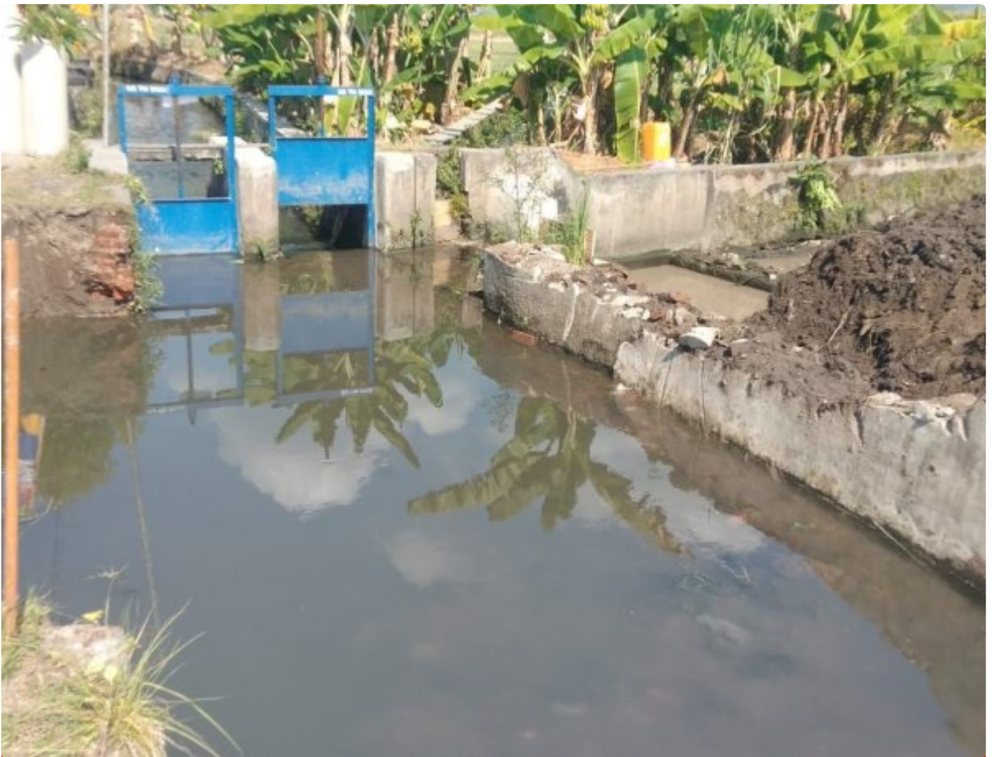
Inilah Lokasi Jembatan Yang Akan Di Buat Satgas TMMD Reg 121
