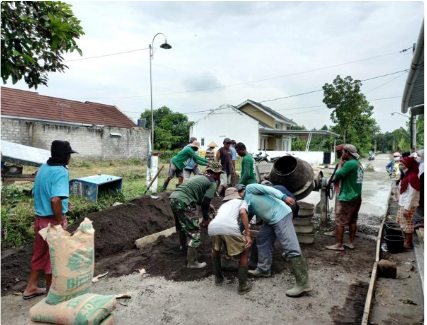
Serka Tenang Suseno, Babinsa Desa Muruh Gantiwarno Klaten Bersama Warga Lakukan Betonisasi Jalan Kampung
